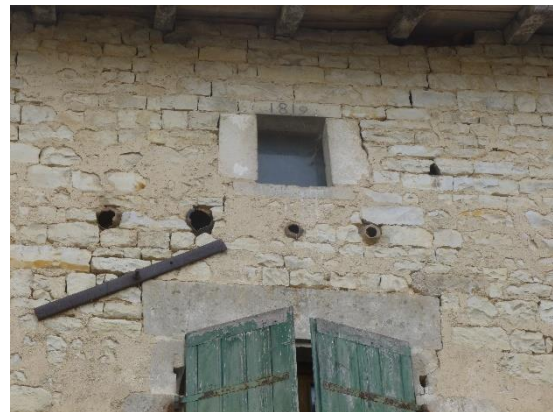
Face à des silos
