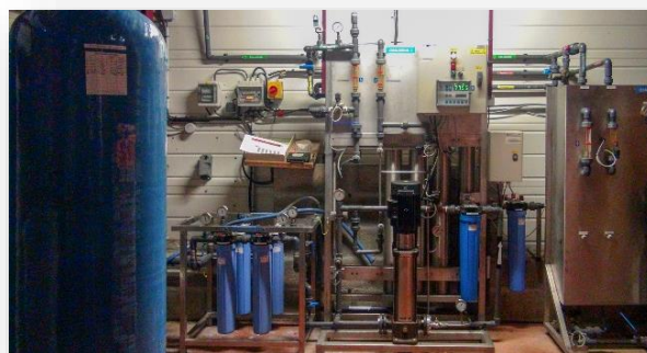
L'osmoseur produit l'eau pour réduire les eaux-de-vie.
